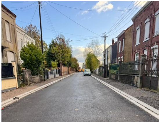
REFECTION DES VOIRIES
