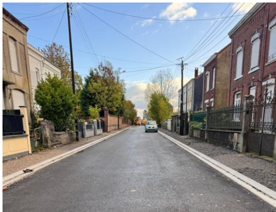
REFECTION DES VOIRIES
