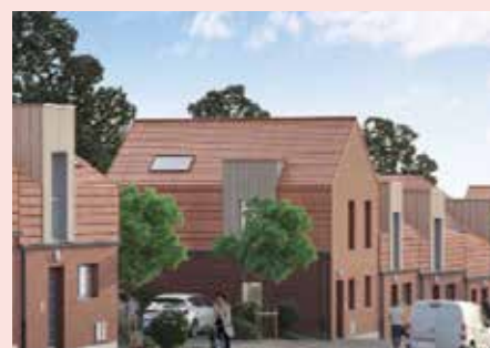
Rue de Boussières : 24 logements
